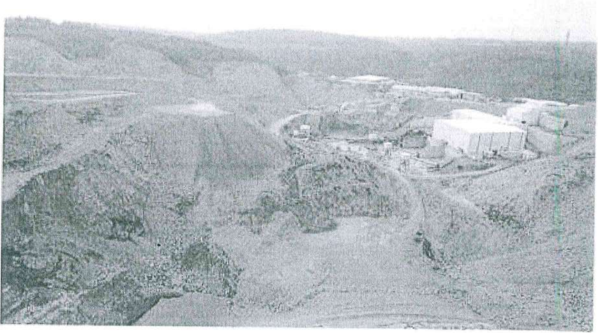
Şekil 4. Agregas (Kumtaşı) maden alanının genel görüntüsü. Sahada yapılan açık işleme faaliyeti sonucunda, kazı alanında belirli kademeler oluşmuş, kapalı alanlar oluşturulan kırma-eleme tesisleri kurulmuştur.
